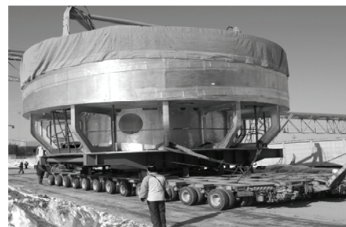
Рис. 6. Транспортировка блока корпуса реактора
