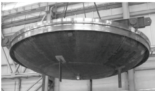
Рис. 3. Укрупнительная сборка днища корпуса реактора
