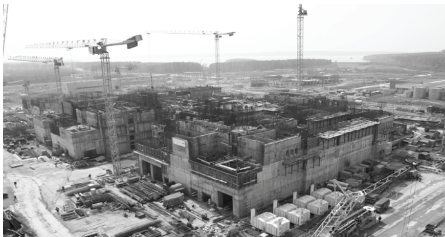
Рис. 2. Общий вид строительной площадки БН-800
