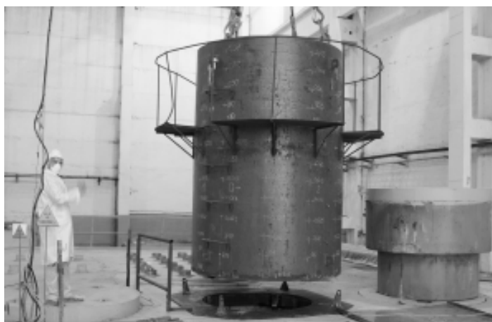
Рис. 4. Установка контейнера К-1 над отсеком хранилища
