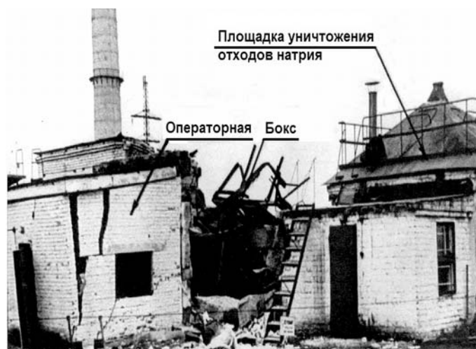
Рис. 4. Последствия взрыва водорода при использовании пароводяного способа нейтрализации остатков натрия в ХЛО (фото 1979 г.).
