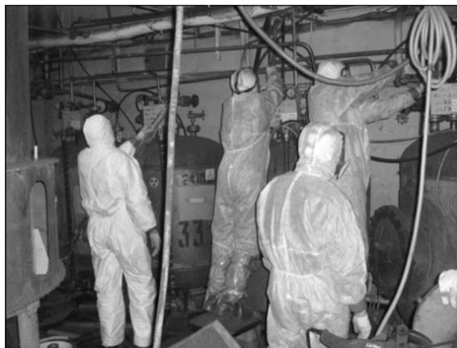
Рис. 2. Демонтаж технологических трубопроводов
