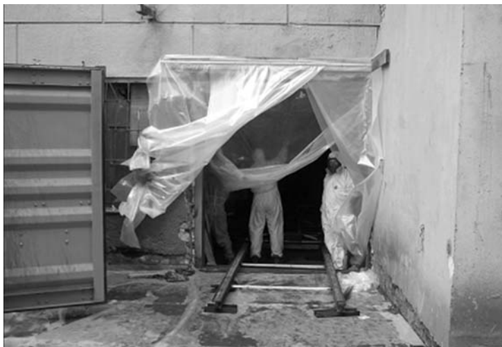
Рис. 4. Проем в стене радиохимического стенда и подкрановые пути
