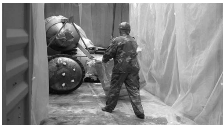
Рис. 7. Погрузка крупногабаритного радиационно-загрязненного оборудования в контейнеры транспортные ПУ-2ЭЦ-СТ
