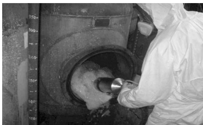
Рис. 8. Пенная дезактивация внутренних поверхностей емкостного оборудования
