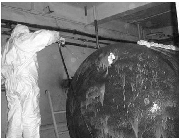
Рис. 5. Нанесение полимерного локализирующего покрытия
