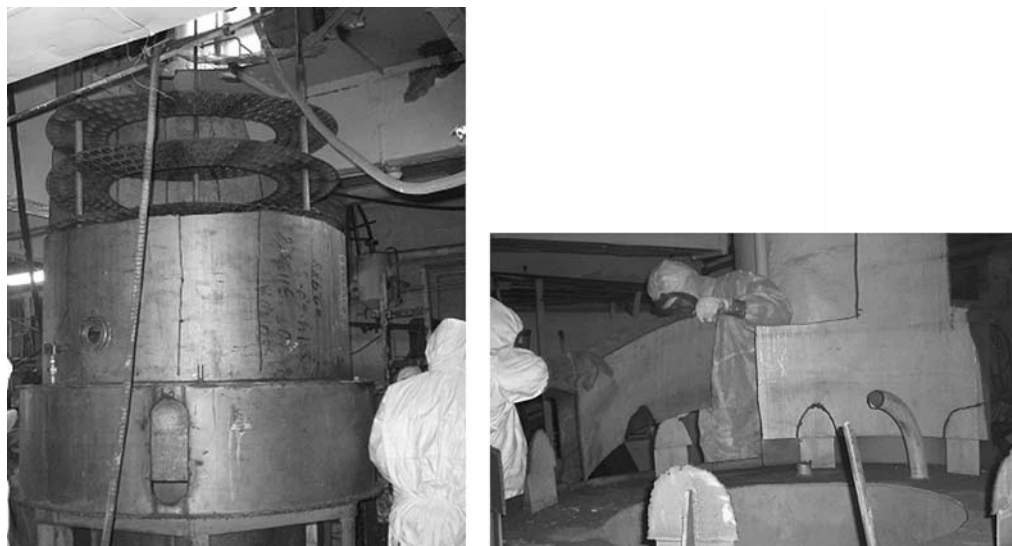
Рис. 3. Демонтаж колонного оборудования радиохимического стенда
